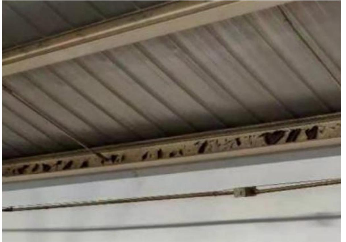
檩条涂层脱落、锈蚀
