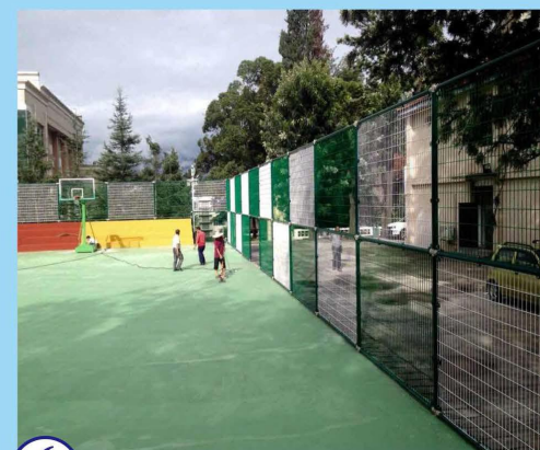
图6 四川西昌学院篮球活动中心防撞围栏正在安装施工（2017年）
