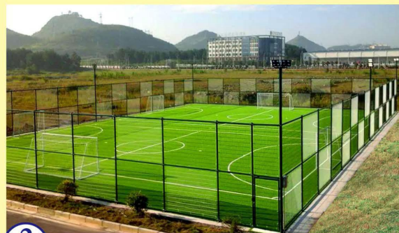
图2 贵州省贵阳市南方汇通足球场白+绿双色彩色立面防撞围栏（2016年安装）
