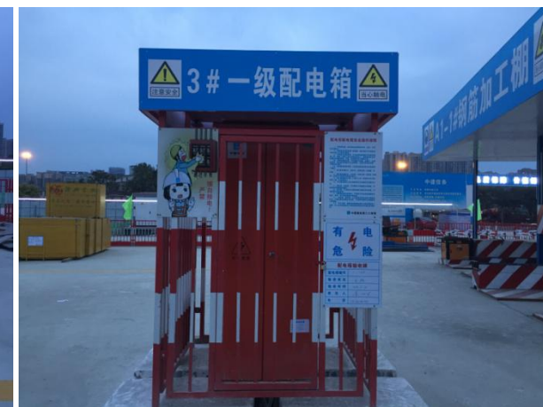
配电箱防护棚
