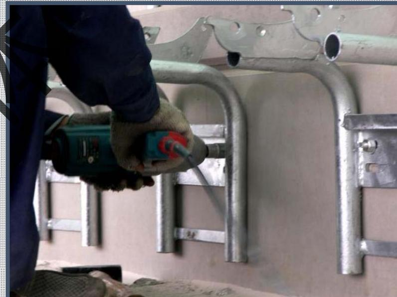
区别于传统联排式支架:1、便于安装及更换 2、杜绝了不同座椅之间的相互干扰。3、更坚固耐用。4、热镀锌工艺,避免室外环境导致的锈蚀。
