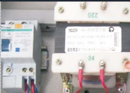
伸缩看台展开使用时，整个系统通电电压为24V，避免因客观因素导致漏电造成的安全隐患。
